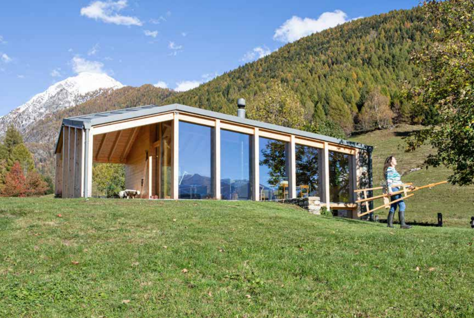
Sopra, la facciata termica con tripli vetri isolanti. Nella pagina accanto, la cucina. Stufa a legna di ghisa Isotta Evo di La Nordica Extraflame; tavolo su disegno con vasi Oops di Ludovica + Roberto Palomba, Bosa; sedie vintage e sedia CH24 di Hans Wegner, Carl Hansen & Søn. ● Above, the thermal façade with insulating triple glazing. Facing page, the kitchen. Isotta Evo cast-iron wood stove from La Nordica Extraflame; custom-designed table with Oops vases by Ludovica + Roberto Palomba, Bosa; vintage chairs and CH24 chair by Hans Wegner, Carl Hansen & Søn.
